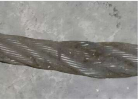
DETERIORO POR USO
